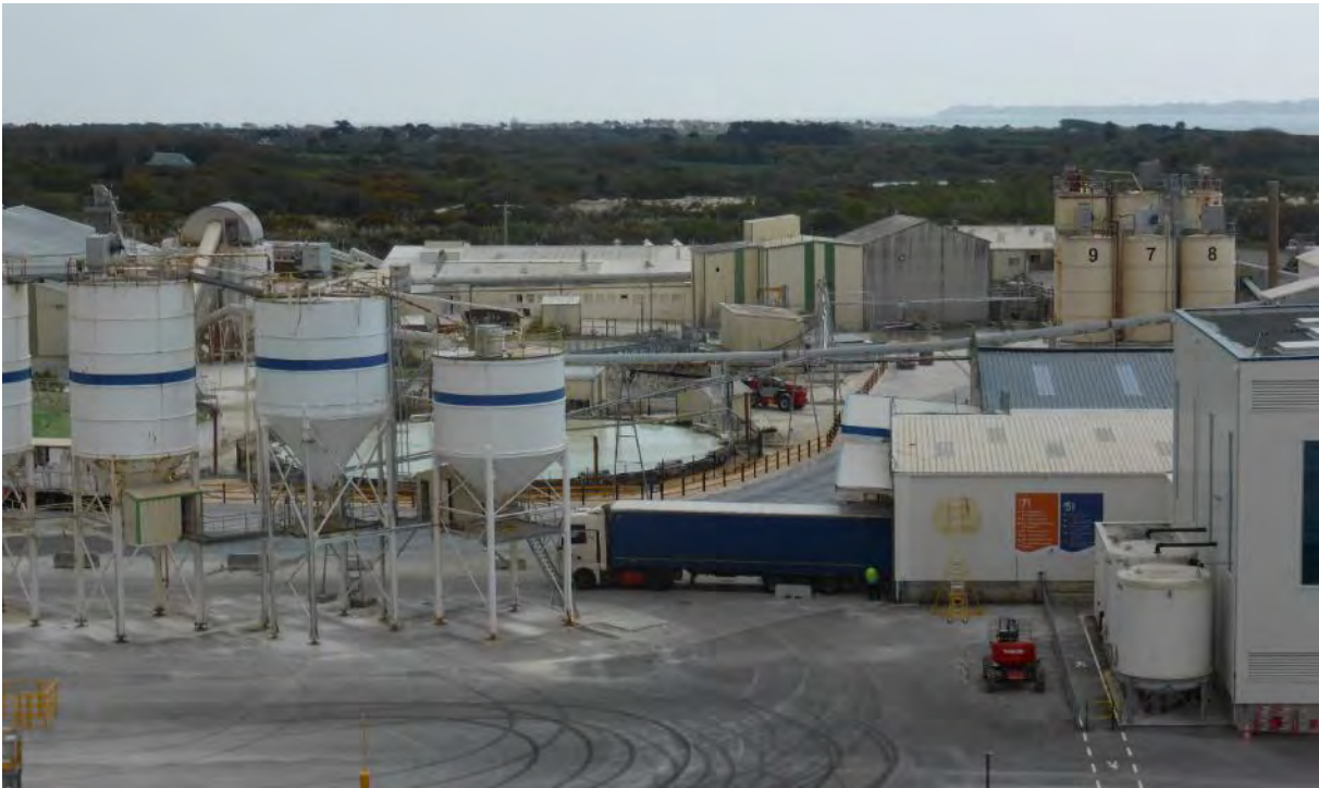
Figure 39 : Quai d'expédition depuis l'usine de Lanvrian (ENCEM)
