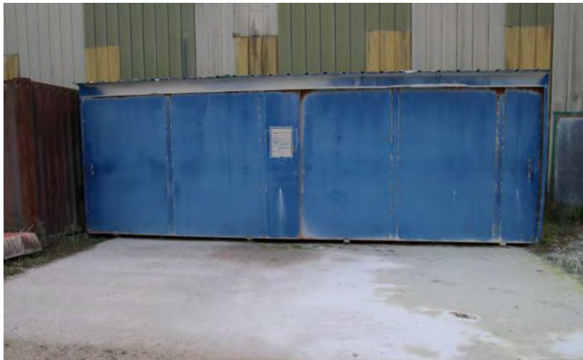
Figure 45 : Cuve de stockage de GNR et aire étanche (Lanvrian) (ENCEM)
