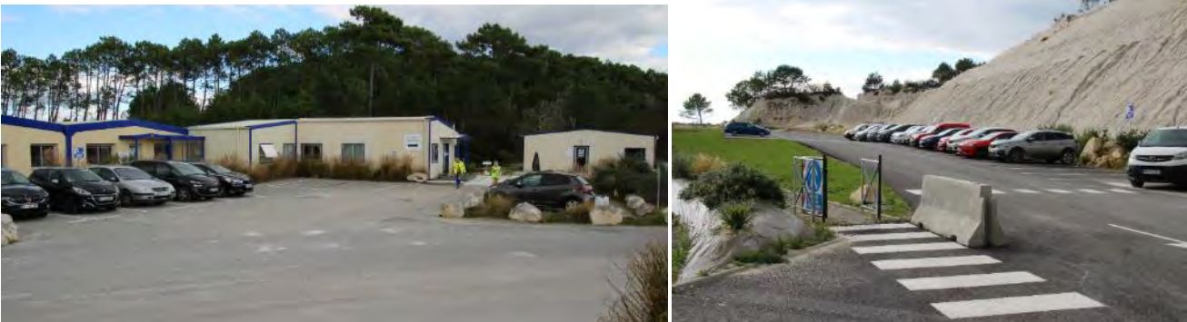
Figure 41 : Aire des bureaux (à gauche) et parking pour les employés et les visiteurs dont l'accès piéton est sécurisé (à droite) (ENCEM)
