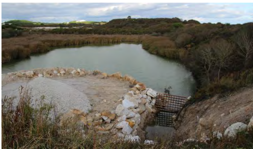
Figure 32 : Exutoire du bassin Sud Lanvrian avant passage sous RD 152 (ENCEM)
