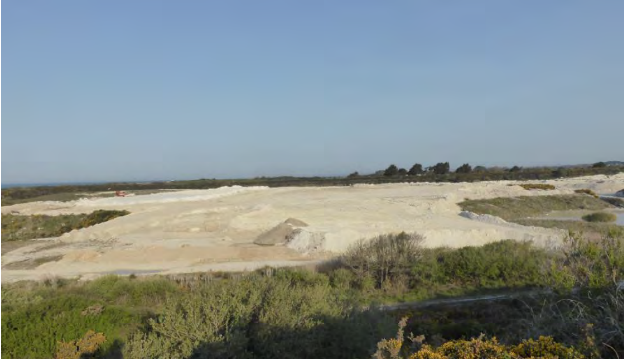
Figure 20 : Zone Sud Lanvrian en cours de remblayage (ENCEM)
